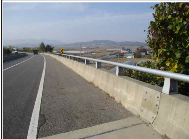
난간 및 연석 전경
